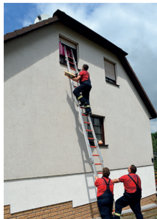
Mit Hilfe der Feuerwehr wurden in Lichtenwalde am Haus von Familie Schwalbe zwei Mehlschwalbennisthilfen angebracht. © Lutz Röder
