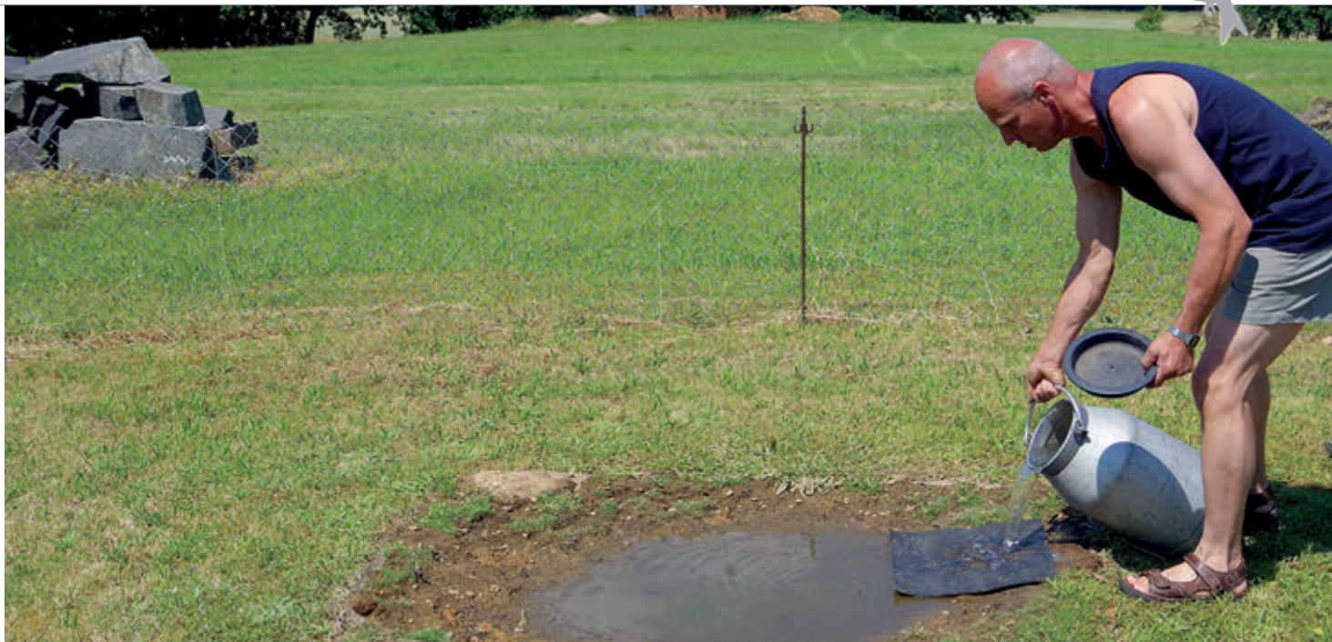
Eine Lehmputze muss regelmufig mit Wasser versorgt werden. Ina Ebert
