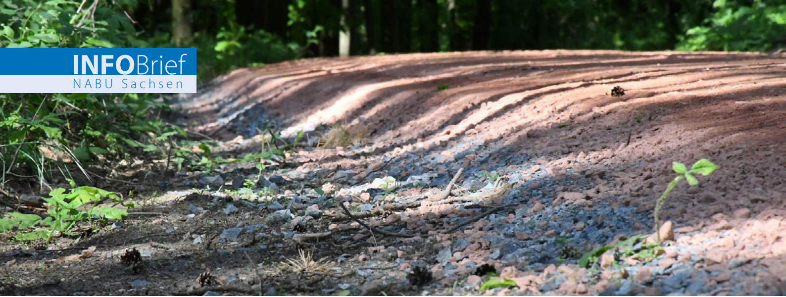
Der straßenähnliche Wegbau behindert die Auenbewässerung. Foto: Renate Wilhelms
