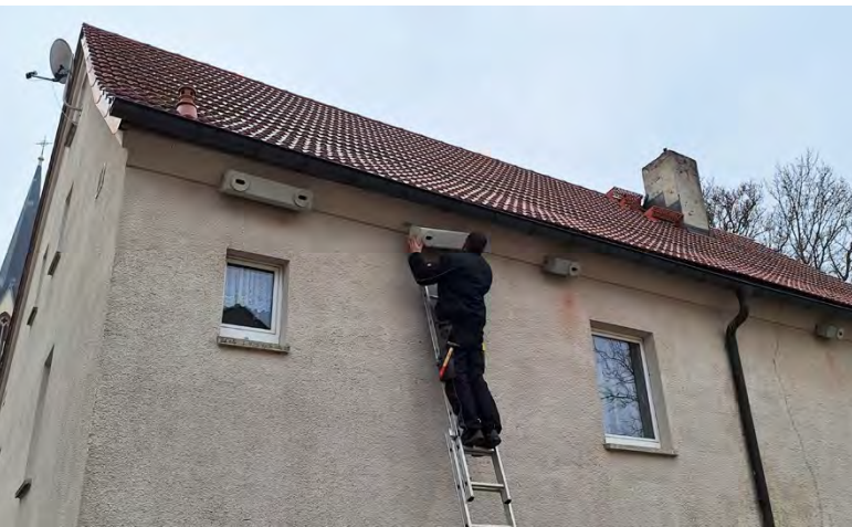
Anbringen der Mauerseglernistkästen. Foto: Berthold Löckelt
