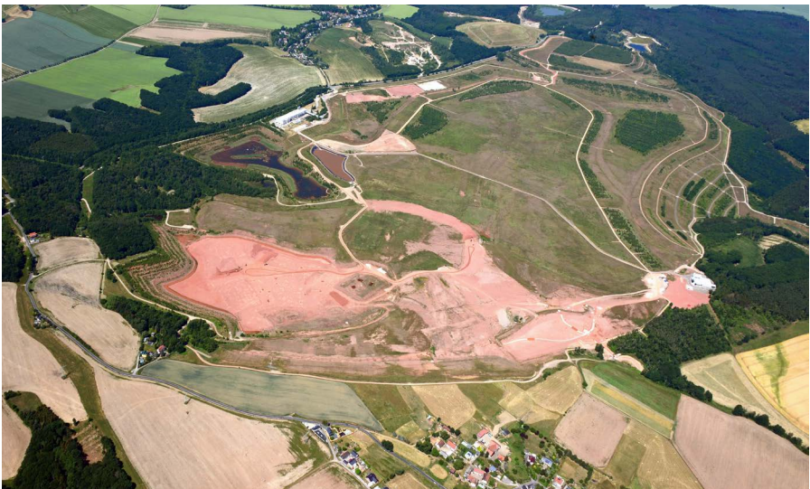
Abb. 3: IAA Helmsdorf zum Ende der Sanierung, 15.06.2022, © Wismut GmbH
