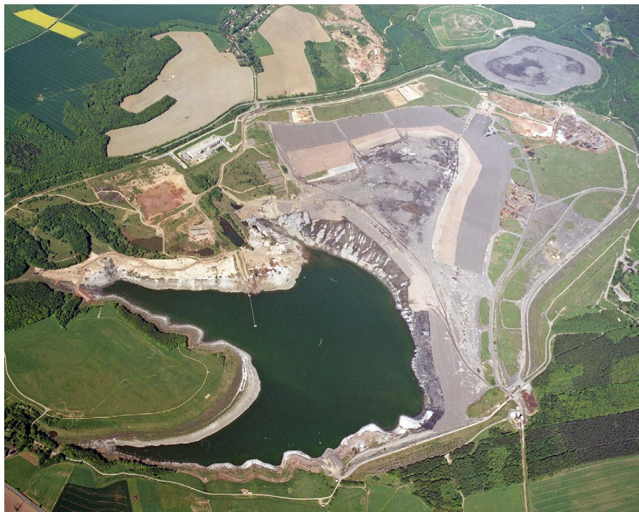
Abb. 2: IAA Helmsdorf in der Sanierungsphase (2002), © Wismut GmbH
