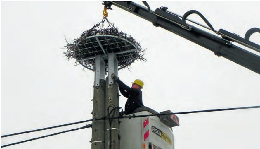
*Weißstorch-Nest in Neuvolkersdorf - Sicherung und Höherlegung eines von den Störchen auf einem Doppelmast selbstgebauten Nestes auf eine Stahlplattform durch die ENSO NETZ (die auch die Kosten übernahm). Alle Fotos: P. Hummitzsch*
