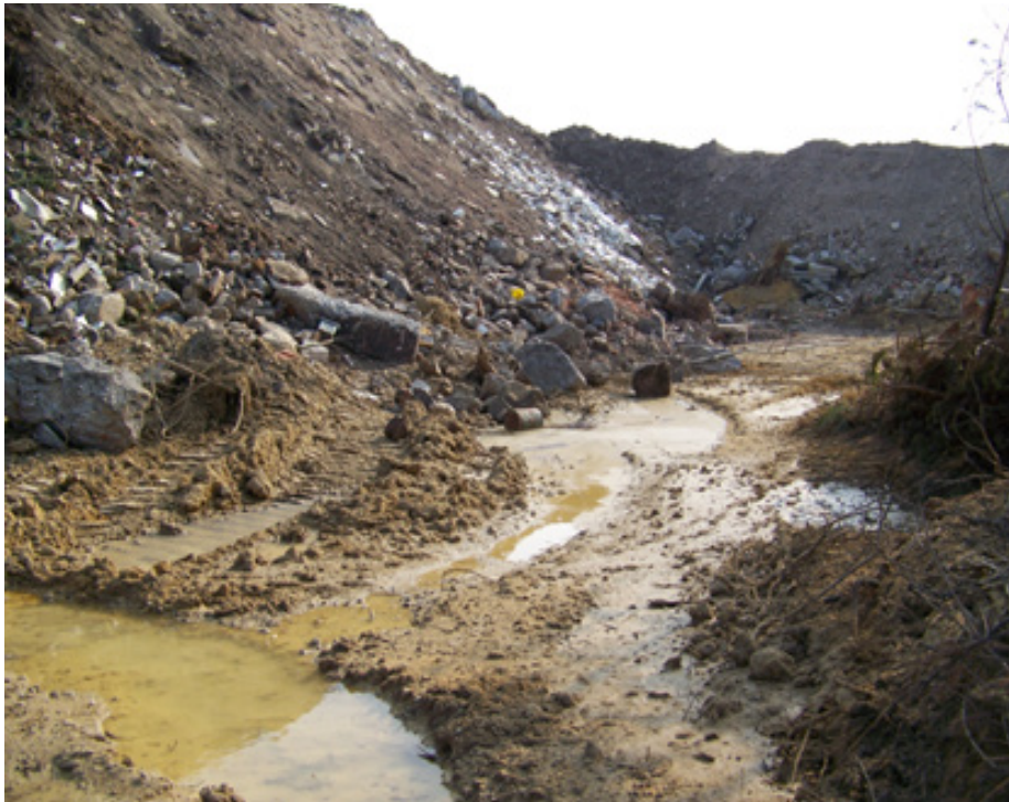
Baustoff-Verkipfung in der Kiesgrube Ottendorf-Okrilla. Das eindringende Sickerwasser löst Nähr- und Schadstoffe, die wegen der fehlenden Sperrschicht ungehindert in die Kiesschichten und ins Grundwasser eindringen und dadurch auch die Moore schädigen. Foto: Holger Oertel
