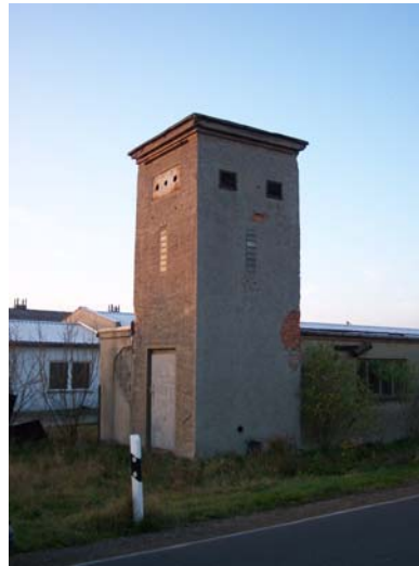
Trafohaus Liebersee vor der Sanierung
