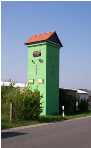
Trafohaus Liebersee Ausbau 2005/2006
