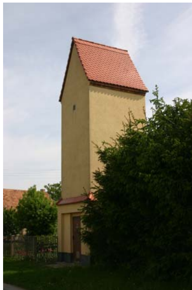
Trafohaus Beckwitz Übernahme von ENVIA Ausbau 2006 geplant
