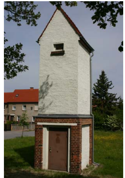
Trafohaus Taura Übernahme von ENVIA Ausbau 2005/2006
